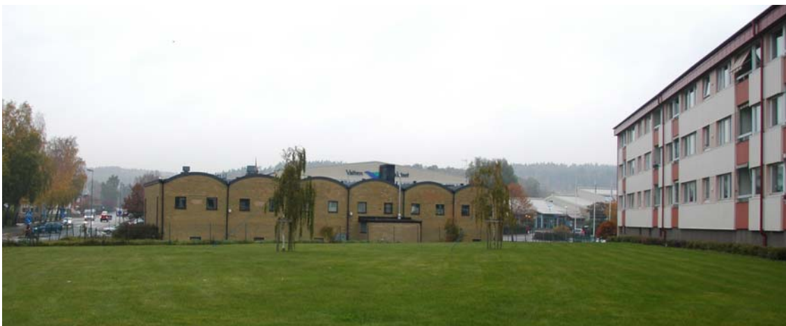
Bild 4 I fonden syns Telestationens karaktäristiska siluett. Till höger på bilden syns det västligaste bostadshuset på intilliggande fastighet. Bakom Telestationen skymtar Vattenpalatset.
