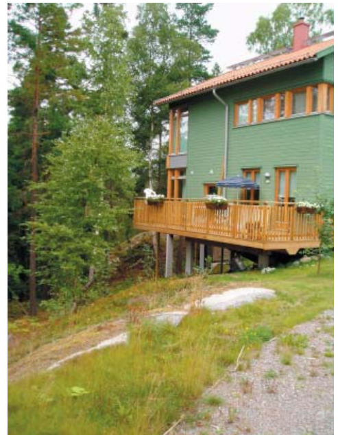
Huset låter sig anpassas till terrängen utan sprängning och stora slänter. Vaxholm.
