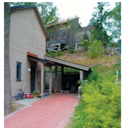
Carportar och andra komplementbyggnader ska ges en stor gestalningsomsorg utan att dominera. Genom att undvika asfaltering ökar infiltrationen av dagvatten. Vaxholm.
